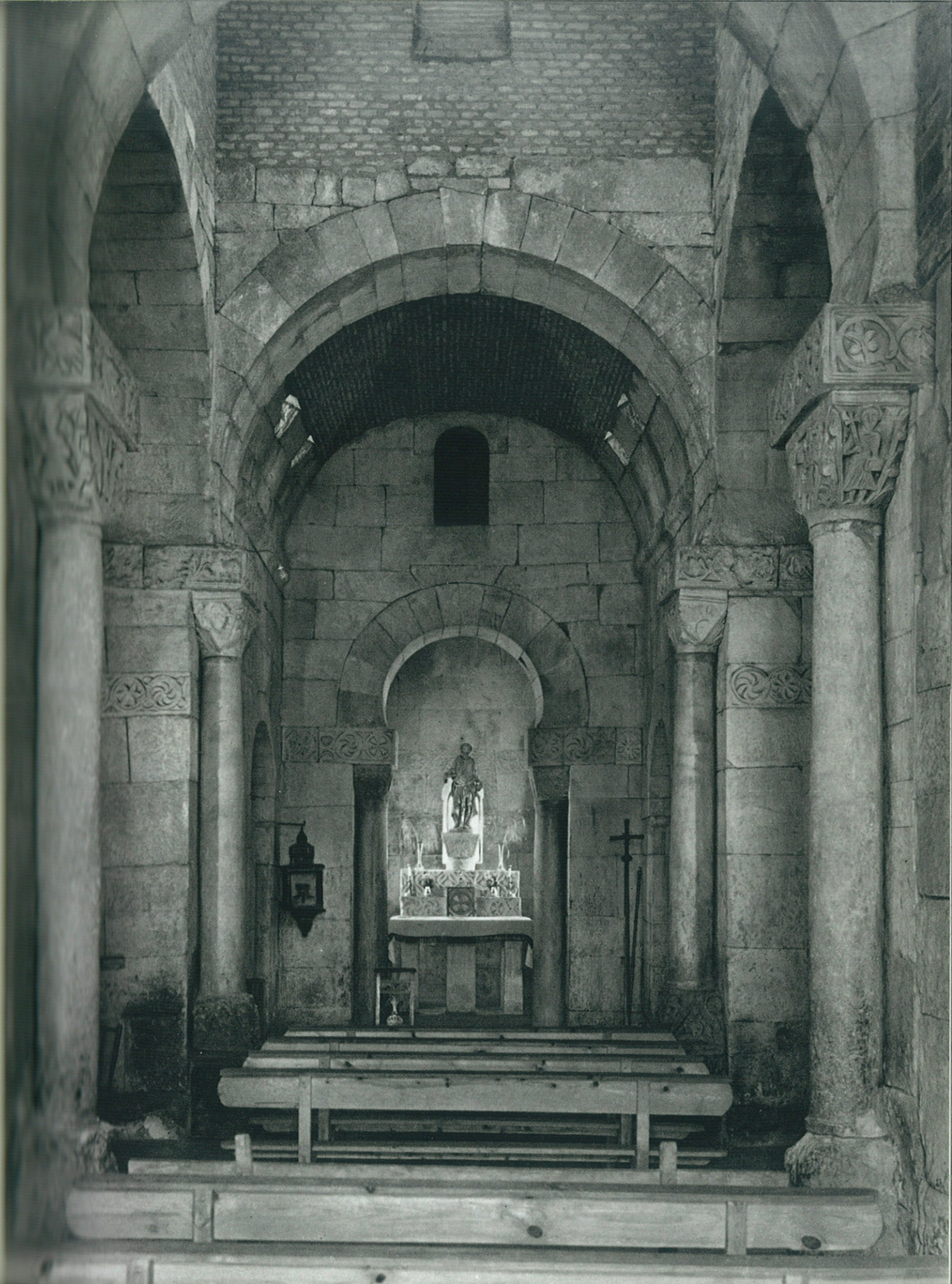
99 - SAN PEDRO DE LA NAVE. INTERIOR
